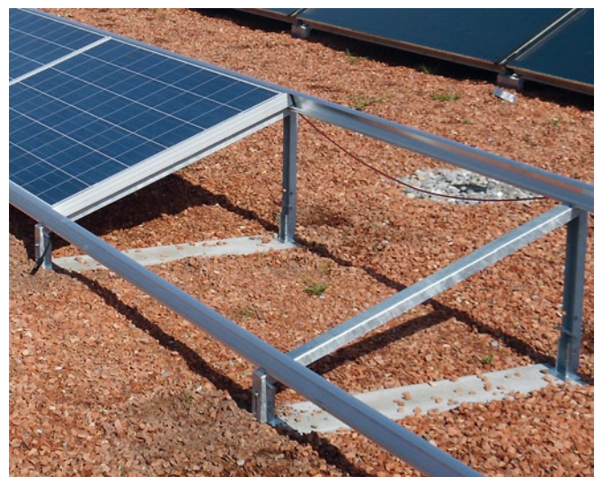
Einbau der Flachdachaufständerung auf einer Druckverteilungsplatte (Betonsockel)
