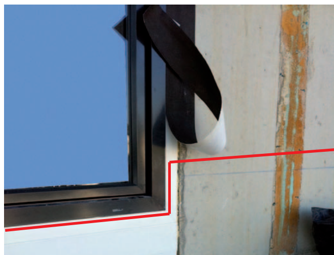
Abb. 20: Winddichtungs- oder Schlagregendichtungsbänder im Flachdachanschlussbereich hochklappen
