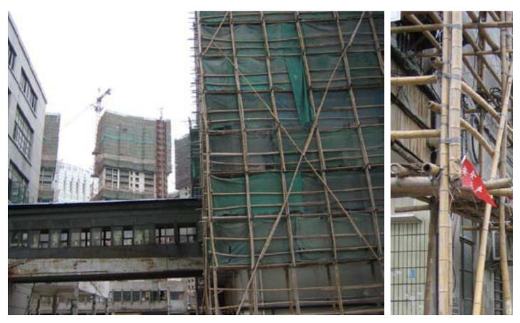
Baugerüst bis 10 Stockwerke wird mit Bambusstangen ausgeführt
