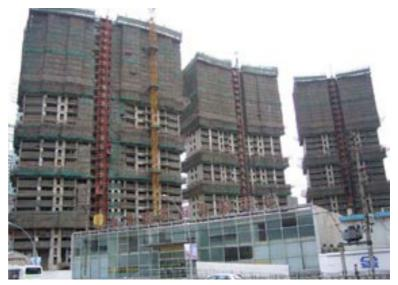
Grössere Projekte werden mit Stahlrohren und Kupplungen erstellt
